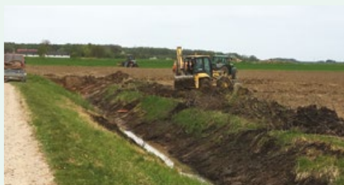
Meliorācijas grāvja un izteku tīrīšana. Avots: ZS „Vilciņi-1” arhīvs
