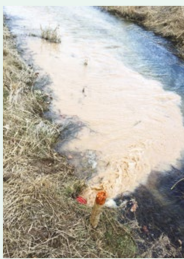
Nosēdumu izplūde no drenu sistēmas.
