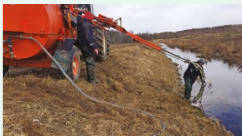
Meliorācijas sistēmas skalošana.
